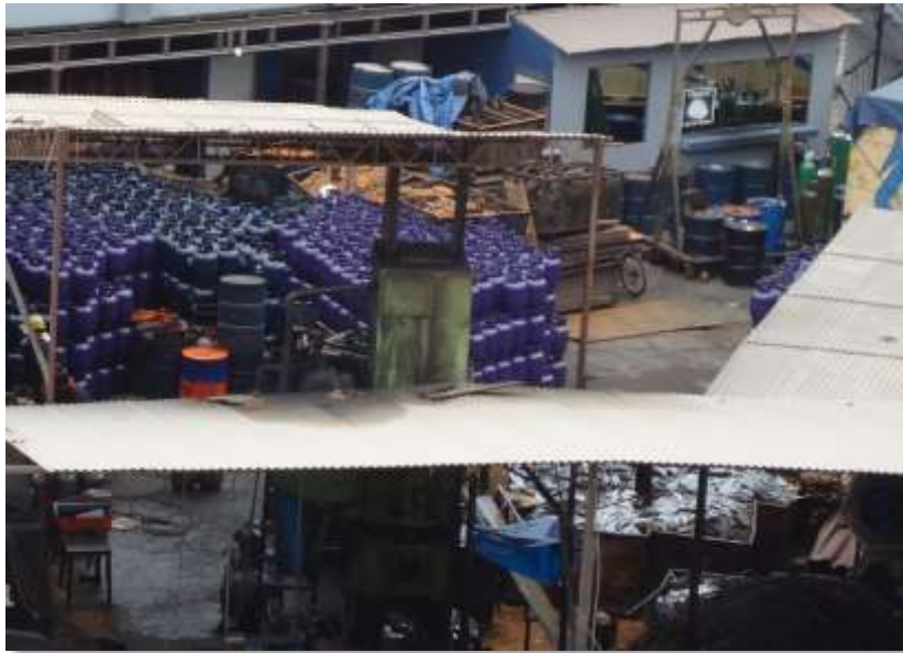
Foto N° 3: Vista interior de la planta donde se fabrican los balones de gas, foco de contaminación auditiva recepcionada en la Primera y Tercera Etapa del Condominio Villa El Sol .
