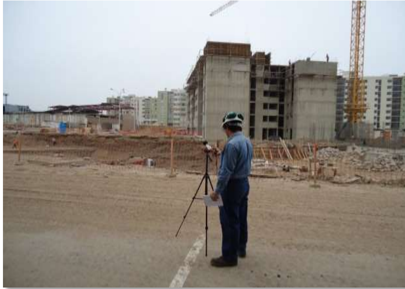
Foto N° 2: Monitoreo de ruidos en la Tercera Etapa (en proceso de construcción) que será afectada por los ruidos generados por la fábrica de balones de gas ubicada en el área colindante.
