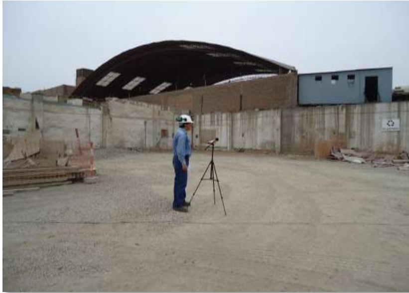
Foto N° 4: Vista de la parte posterior de la fábrica de balones de gas, donde se observa que el techo del hangar está totalmente descubierto por donde se agudiza la contaminación auditiva.
